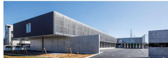
至誠館は県内有数の企業の社員寮である。外国人、シングルマザー、障がいのある方も抱擁する、茨城県のリーディングカンパニーとしての品格の体現であり、会社で働きたいと思えるインセンティブとなる。敷地は交通量が多い国道125号に面する奥行きをもつ土地である。L型の平面形状の建物の奥行方向の一辺に男子寮を、奥の一辺に女子寮を配置した。コンクリート打放しの壁が道路と平行に立ち、越境する2階部分が通行する車からのアイキャッチとなる。その2階部分が長手方向に浮遊し、サーフィスのアルミ製水平ルーバーが奥行を強調する。入口のコンクリート打放しの門扉には黒御影石の塊が挿入されている。刻まれた「至誠館」の文字は、社長の思いに応えた会長の筆である。そこに闇彩商事という企業の比類なき品格が醸し出されている。
